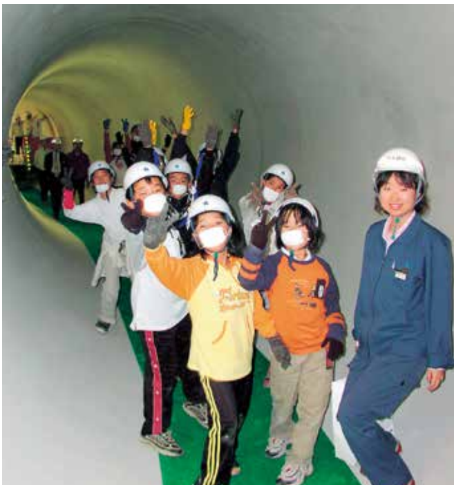
下地雨水幹線 直径3.0m 2001年(平成13年)12月
