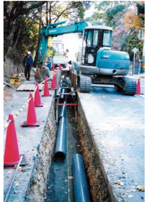
かん ちよっけい う 下水道管(直径25cm)を埋める工事
