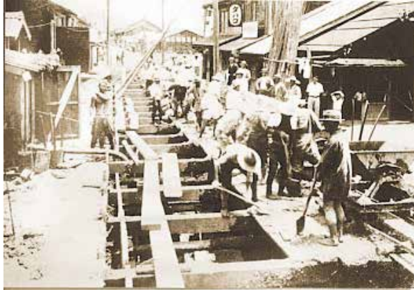
ふなまちかんせん 1933年(昭和8年) 船町幹線工事
