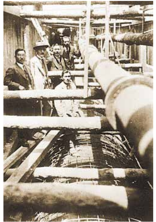
かみでんまちょう かやまち 上传馬町と萱町の工事
