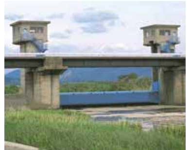
豊川放水路分流堰
